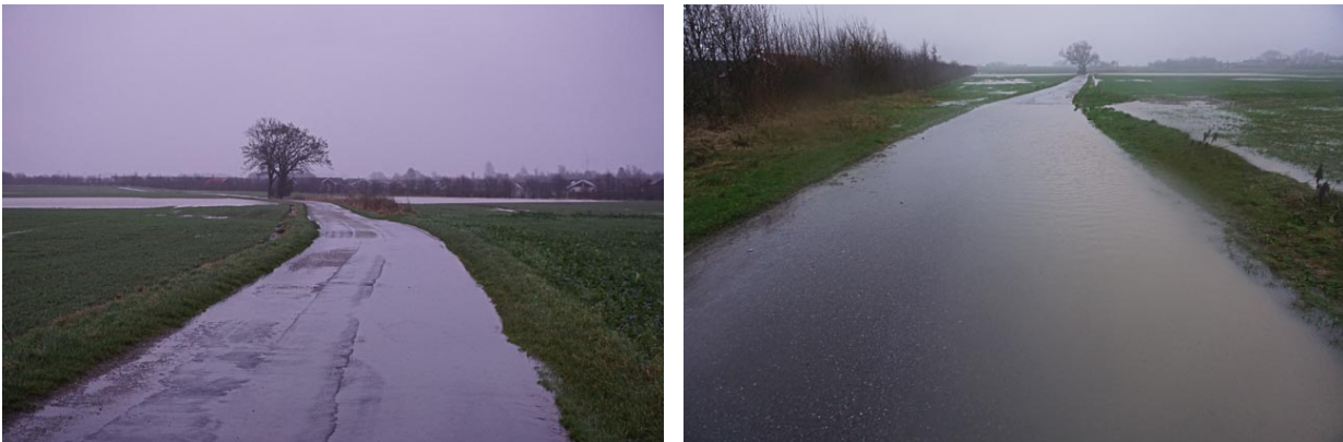
Figur 2.: Ved kraftig regn løber vand fra marker, veje og tagflader via vejen Birke videre ind i sommerhusområdet. Birke set fra sydvest og fra nordøst. 26.12.2015
