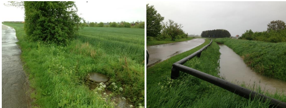
Figur 1: Til venstre ses L69 med opstuvning til dækselkote ved vejen Birke. Til højre ses en meget belastet Landkanal.
