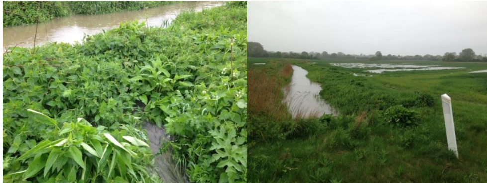
Figur 2: Overløb fra Landkanalen til naturlig lavning opstrøms svinget ved Birke.
