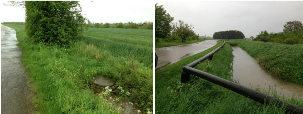
Figur 1: Til venstre ses L69 med opstuvning til dækselkote ved vejen Birke. Til højre ses en meget belastet Landkanal.
